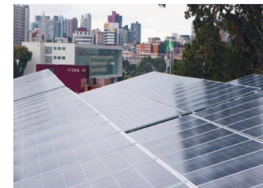
A usina fotovoltaica da Celepar é uma das maiores da cidade de Curitiba. Contemplam um total de 248 painéis, ocupando uma área de 370 m<sup>2</sup>, que produziu em 2021 um total de energia de 79594 kWh, gerando uma economia de, aproximadamente, 96 mil reais na conta de energia elétrica da companhia.
