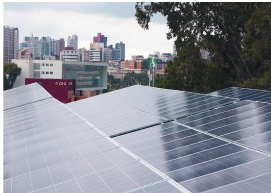
Construção de uma das maiores usinas fotovoltaicas da cidade de Curitiba, com capacidade total de 60,48 kW. Foram instalados 192 painéis que devem produzir mais de 80.000kWh de energia por ano, ocupando uma área de 370m<sup>2</sup>. O lançamento oficial contou com a presença do secretário Silvio Barros e o compromisso da ampliação da sua capacidade em 2019.
